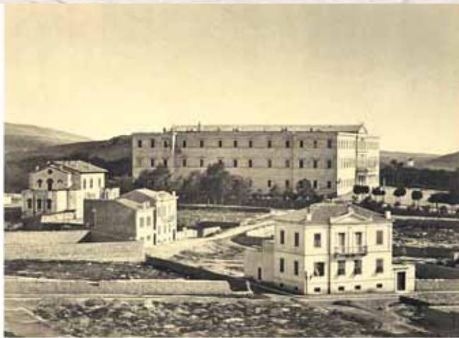
Τα παλιά Ανάκτορα από τον Λυκαβηττό, 1864.
